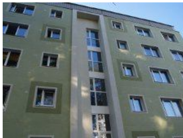
Daudzdzīvokļu ēka pēc siltināšanas
